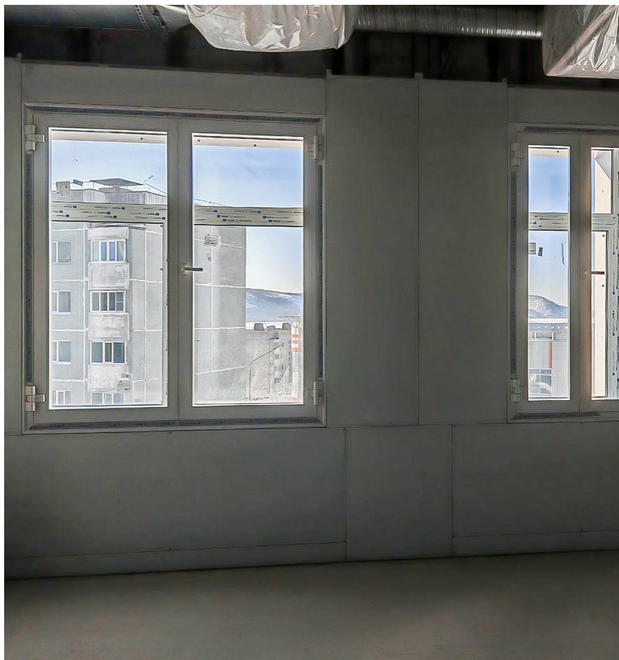
Выполняется монтаж комплексов чистых помещений
